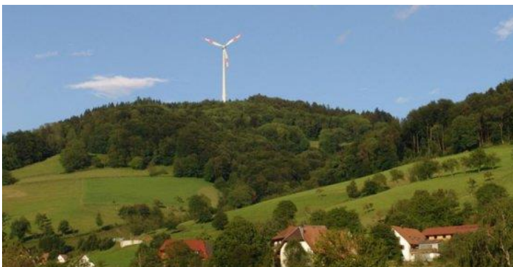
In Freiamt im Mittleren Schwarzwald wird 2013 bereits das sechste Windrad aufgestellt Bild: © Windmühle Freiamt
