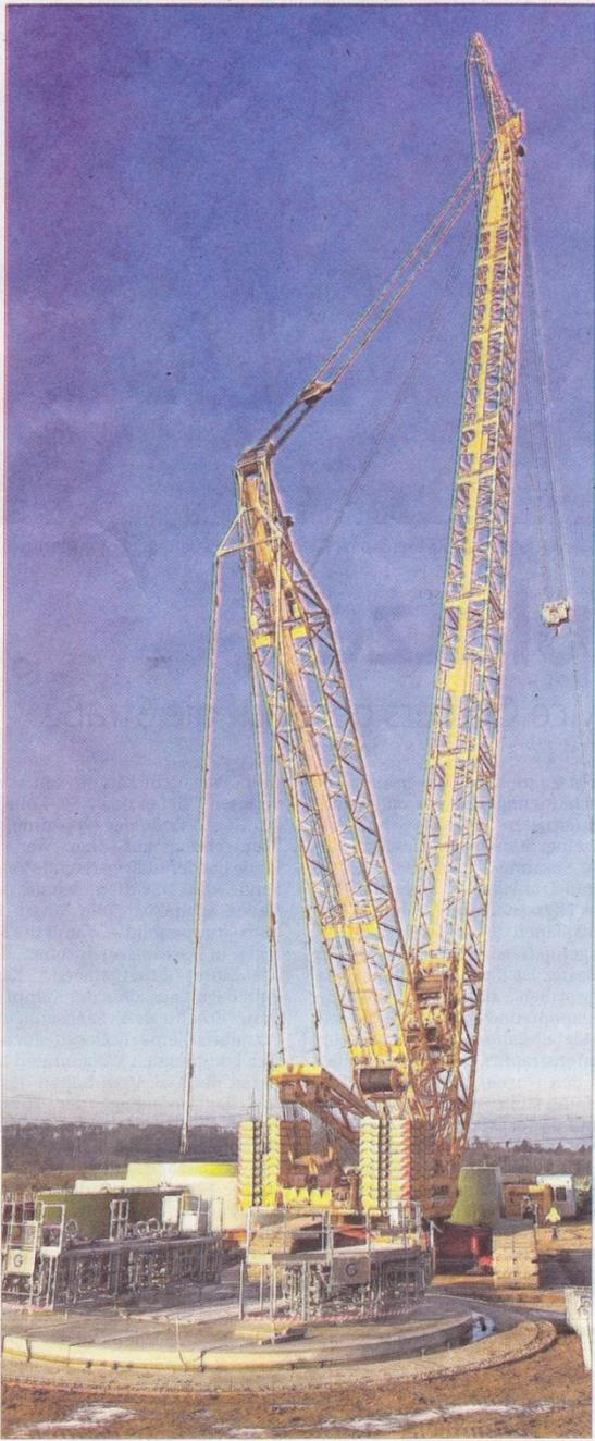
Der nächste Schritt nach oben ist getan: Seit dieser Woche steht an der Windrad-Baustelle in Ingersheim nun der 100 Meter hohe Kran, mit dessen Hilfe der gut 80 Meter hohe Turm der Anlage hochgezogen werden soll. Mitte, Ende Februar soll er stehen. Die Nabenhöhe des Windrads wird einmal 138 Meter betragen, die Höhe bis zur Flügelspitze 179 Meter. Foto: Martin Kalb
