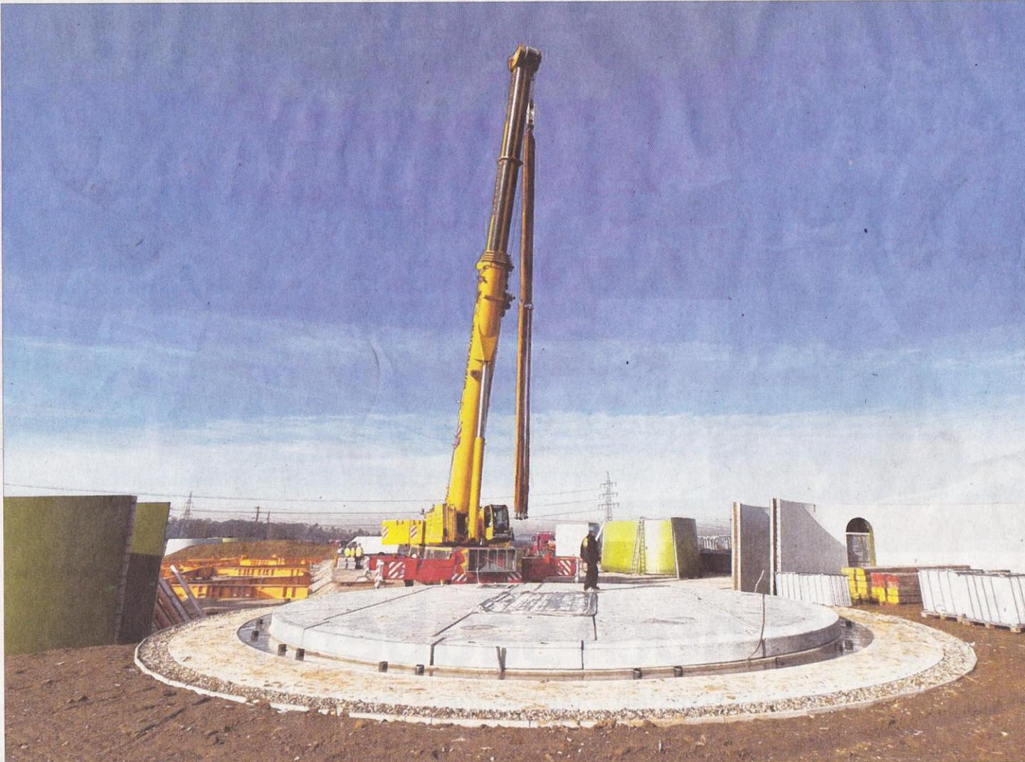
Bislang muss man sich die Ingersheimer Windkraftanlage noch vorstellen, doch die Vorbereitungen zum Aufbau laufen. Zurzeit montiert ein spezieller Kran die Teile für den Turm. Ein noch höherer Kran wird die einzelnen Segmente dann aufeinanderstapeln.
